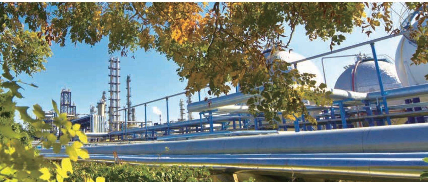
Proyecto de optimización y mejora de eficiencia del procesamiento de petróleo ruso de Liaoyang Petrochemical
